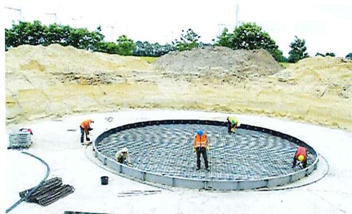
22,5 m Durchmesser misst der Sockel einer Windkraftanlage der 3-MW-Klasse. In das Fundament werden 900 m<sup>3</sup> Beton und 90 to Stahl eingearbeitet.
